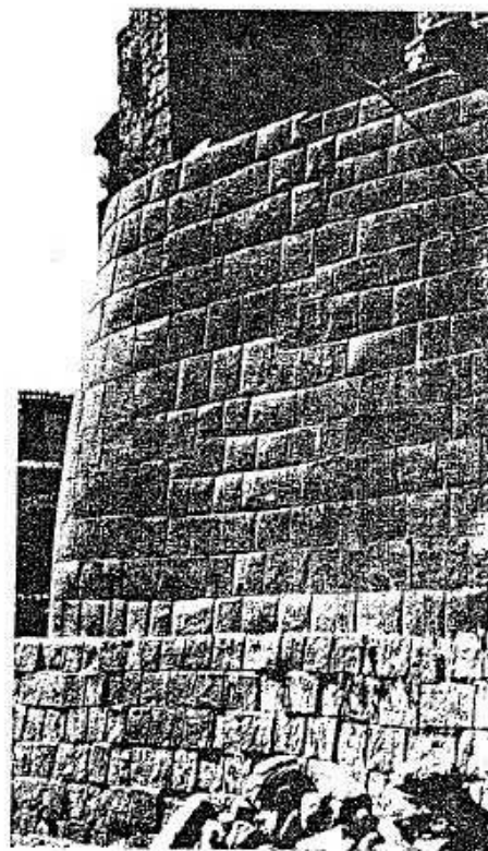
403. Cuzco, muro esculpido de Coricancha, bajo el extremo oeste de la iglesia de Santo Domingo, siglo xv.
