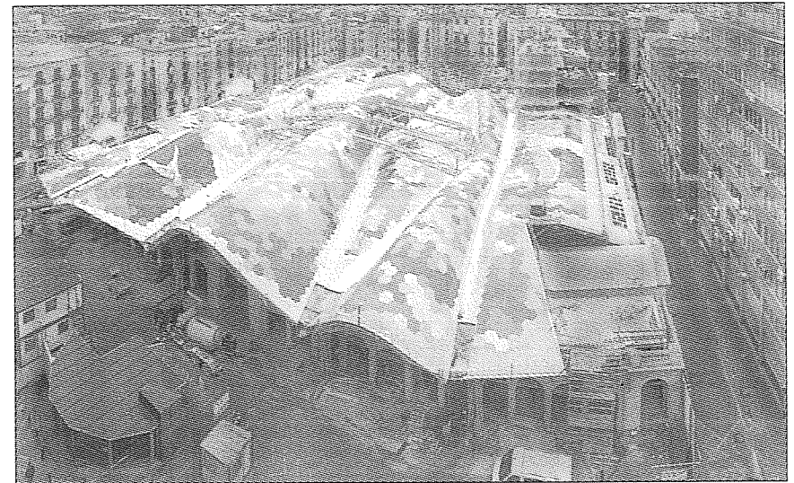
Figura 11.10. Reconstrucción del mercado de Santa Caterina a cargo de Enric Miralles y Benedetta Tagliabue. Los hexágonos pavimentan, por selección cultural, la compleja cubierta ondulada (fotografía de Benedetta Tagliabue).
